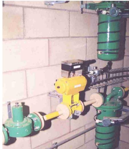
Die Vermeidung der Rückverflüssigung ist ein besonders wichtiger Aspekt weil flüssiges Chlor in der Dosierleitung nach dem Druckreduzierventil, PVC-Leitungen und Armaturen zerstört.
