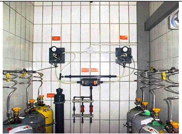
Abb. 23b: System mit Sammelleitung
